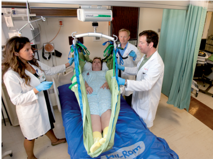
1. ábra. Mennyezetre szerelt emelőszerkezet Forrás: http://stanfordhospital.org
